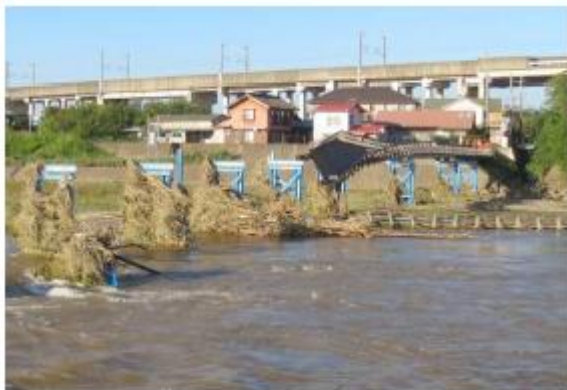
台風により被災し流出した佐野橋
