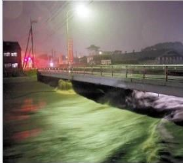
令和元年7月 ゲリラ豪雨による井野川増水：上滝町
